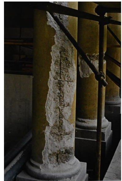
Sanacija stebrov v II. loggie na Rečni strani 1995, arhiv ZVKDS
