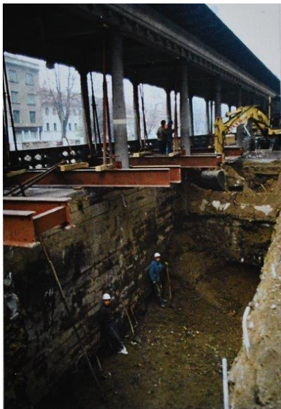
Vpetje stebrov pred betoniranjem 1994, arhiv ZVKDS
